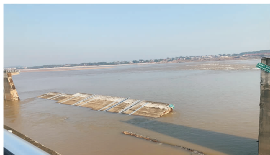
图1 事故船闸倒塌实况
