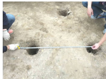
图6 群井渗水试验和含水率测试
