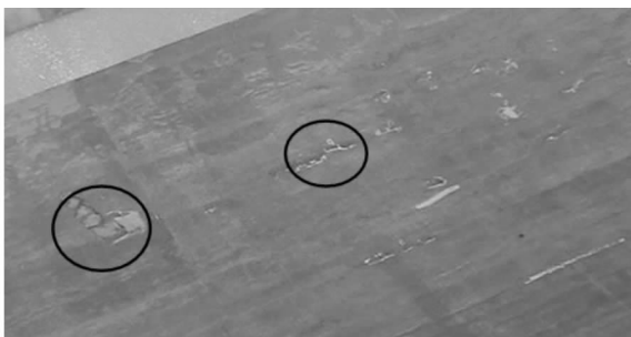
图9 工程反弧段破坏照片
