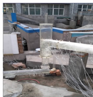
图2 模型安装现场图
