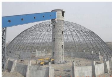
图1 落煤塔结构工程实例
