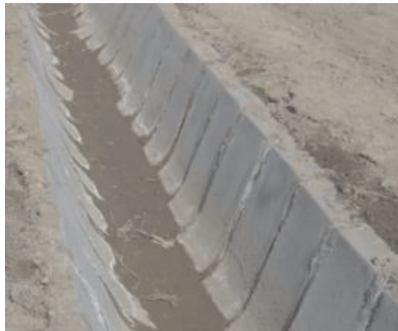
图1 D60U形混凝土衬砌渠道
