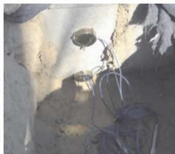
图 4 土压力盒安装
