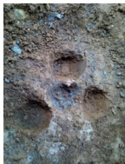
图 3 开挖安置土压力盒孔
