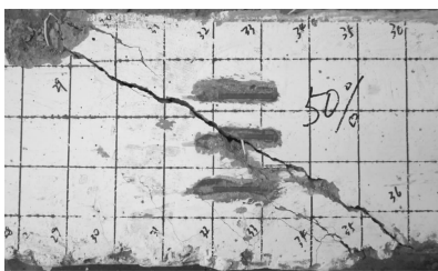
L 3 梁的破坏情况
