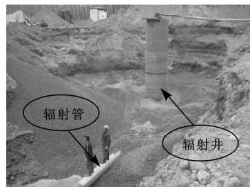
图 3 机械成井、管外换料工艺施工
