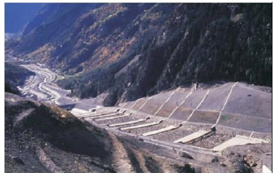
图3 意大利 Val Pola 堰塞体开挖溢流槽及下游拦砂坝<sup>[28]</sup>
