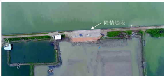
图 2 险情堤段现状航拍
