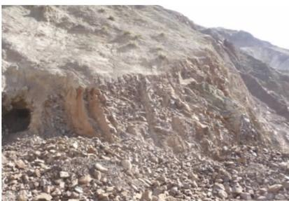
图1 边坡开挖后碎裂结构面
