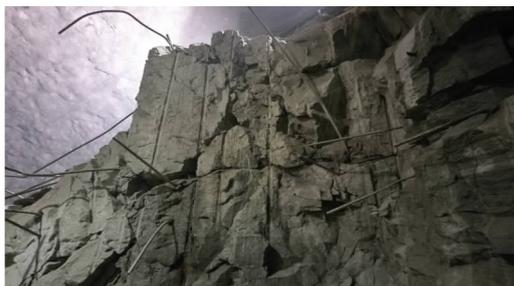
图 7 尾调室中隔岩墙顶部岩体的逐渐劣化现象
