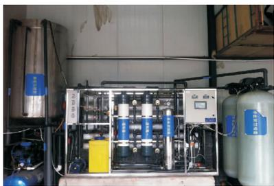
图 1 丰台区 WR-RO 典型技术设备配置现场情况
