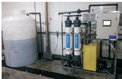
图 2 西城区 WR-UF 典型技术设备配置现场情况
